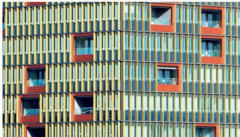
Moderne Fenster und Isolationen reichen nicht aus, um das Effizienzpotenzial von Gebäuden zu nutzen. Es braucht eine gut gewartete Haustechnik. (Bild: Steffen Schmidt / Keystone)
